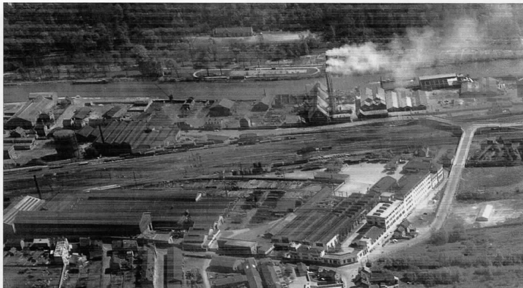
1958-Le Pont Y de Creil, les usines Daydé et Vieille Montagne, et l'ENP.
