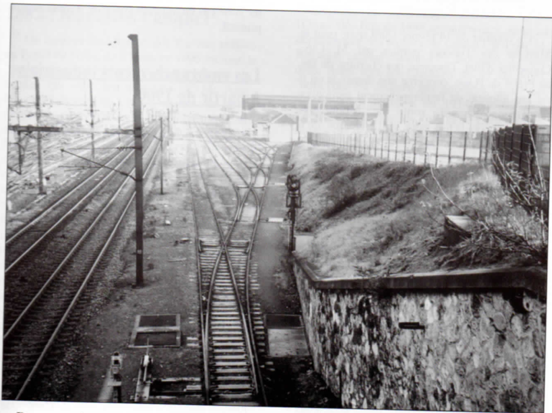
Document 4 : Les embranchements entre les voies ferrées principales et l'actuelle rue Jean Jaurès à Creil, vus depuis le Pont "Y" vers l'ancienne "usine Fichet", puis la gare (Photo Th. D., janvier 2004).
