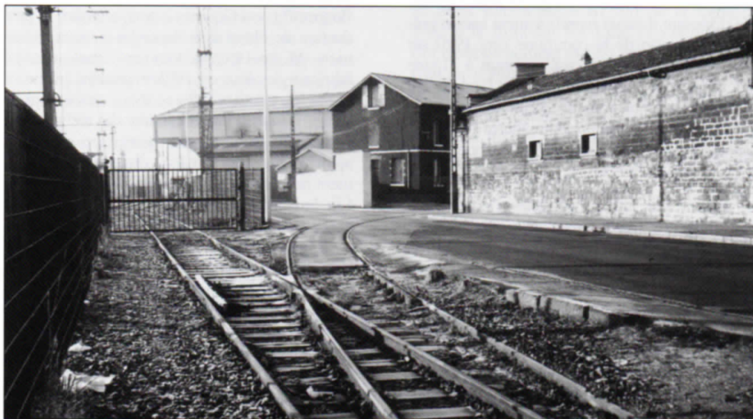
Document 1 : Le dernier embranchement encore utilisé dans la rue des usines : celui de l'entreprise ACOR, anciennes "Forges, Tréfileries et Pointeries de Creil" (Photo Th. D., janvier 2004).
